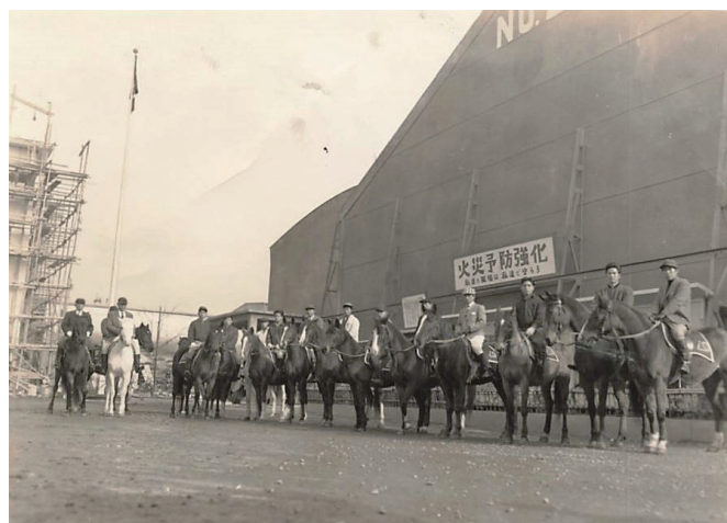
写真6. 建設中の東映俳優会館とNo.2スタジオの前で「高岡騎馬隊」の揃い踏み。
